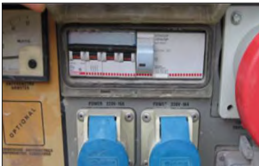
Figura 2-8 – quadro di gruppo elettrogeno con prese a spina e protezione differenziale a bordo [4]
