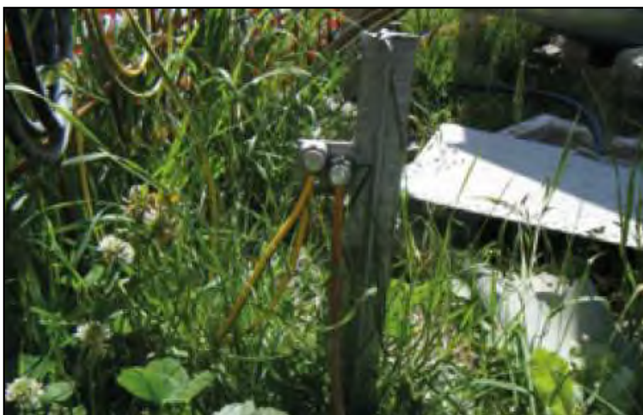
Figura 4-3 - dispersore di terra intenzionale [4]
