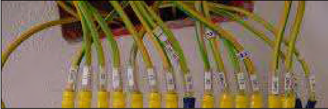
Figura 3-4 – conduttori equipotenziali
