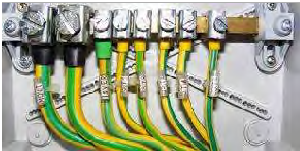
Figura 3-3 - collettore di terra
