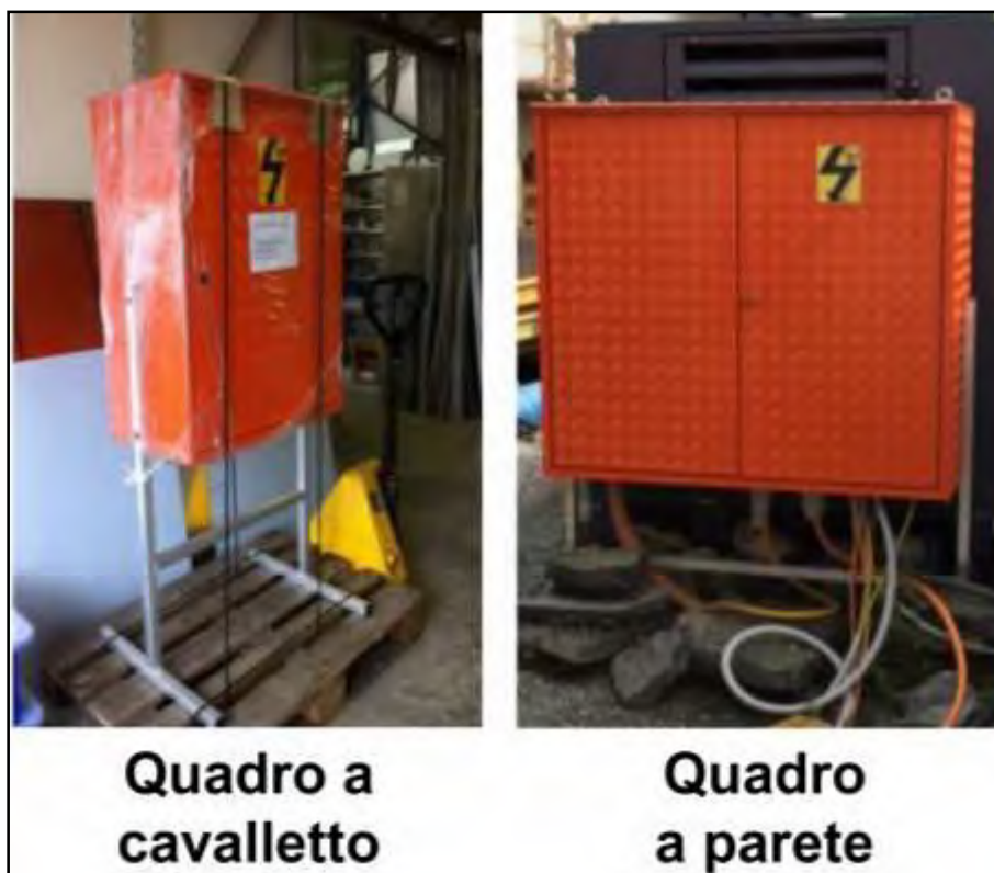
Figura 12-2 - esempi di quadri di cantiere [6]
