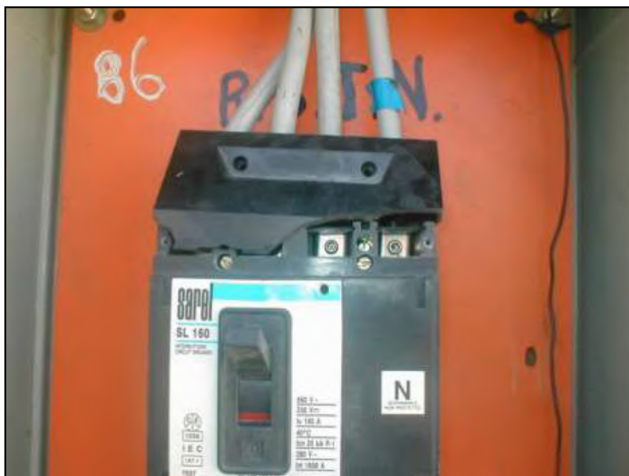
Figura 6-4 - esempio possibile pericolo da contatto diretto
