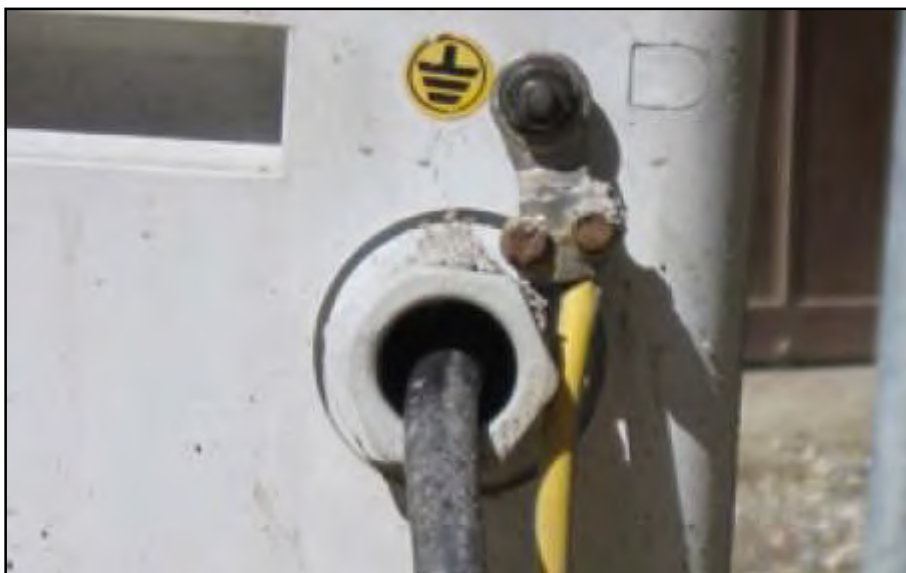
Figura 4-2 - nodo di terra del quadro elettrico principale [4]
